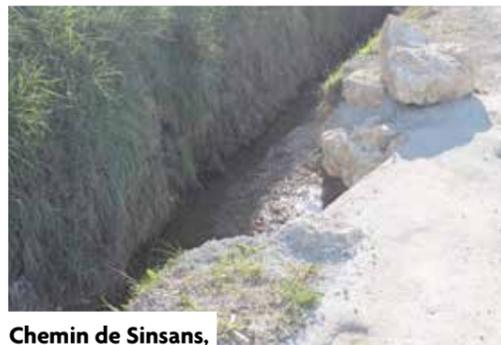
Chemin de Sinsans, reprise chaussée et pluvial et requalibrage des fossés pour un meilleur écoulement de l'eau
